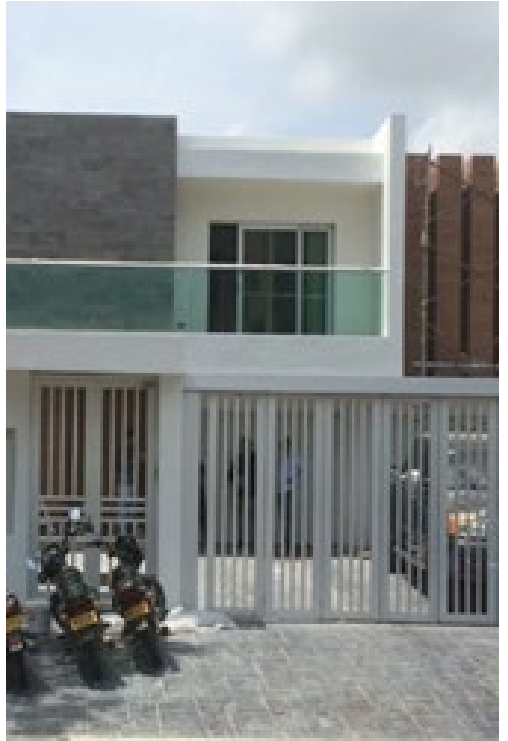
VIVIENDA VG Ubicación: Barranquilla, Colombia. Área Construida: 650 m2 Servicio: Diseño y Construcción Fecha: 2017 Estado: Construido
