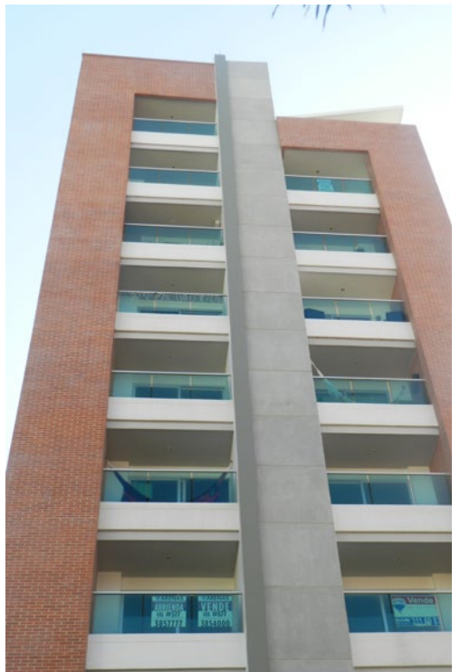
EDIFICIO PORTA ROSSA
