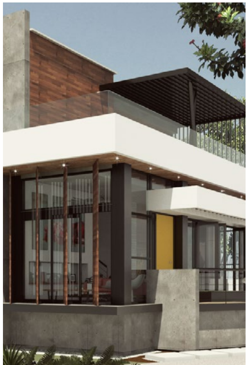
VIVIENDA FA Ubicación: Santa Marta, Colombia. Área Construida: 450 m2 Servicio: Diseño y Construcción Fecha: 2016 Estado: Construido
